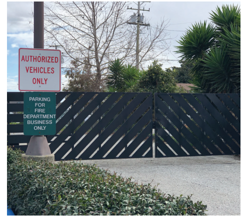
La nueva puerta en la estación de bomberos no. 1 protegiendo el equipo.
